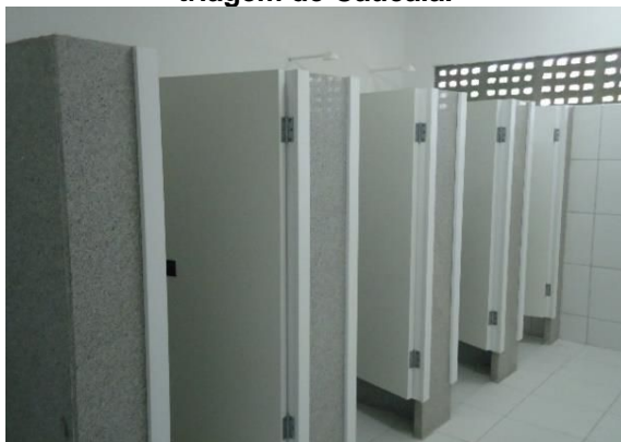
Figura 3.176: Banheiro coletivo do galpão de triagem de Caucaia.
