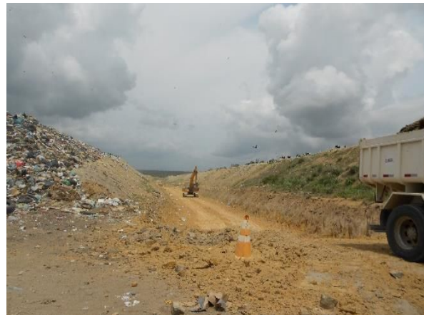
Figura 3.168: Aterro do município de Aquiraz.
