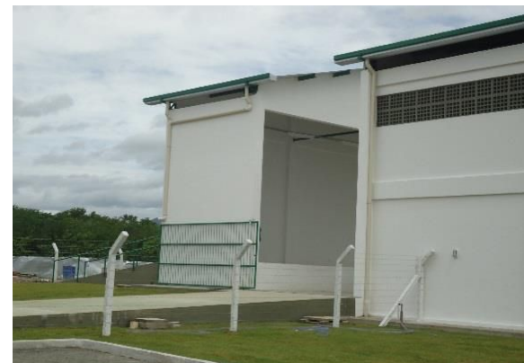
Figura 3.172: Galpão de triagem de Caucaia.
