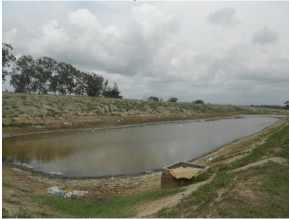
Figura 3.167: Lagoa da estabilização de Aquiraz.
